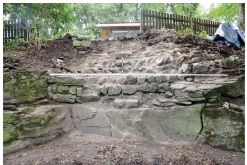
Zabelstein, Fragment der Ringmauer des frühen 12. Jahrhunderts nach der Sanierung, 2015. Deutlich erkennbar ist hinter dem kleinformatigen Handquadermauerwerk der Außenschale das Fischgrätmauerwerk (opus spicatum) des Füllwerks (Foto: Büro für Burgenforschung, Joachim Zeune)
