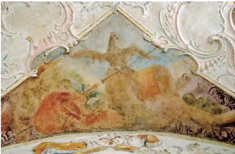
Deckenfeld über dem ehemaligen Hochaltar. Die Schäden durch das Strappo-Verfahren sind, bis auf die Randbereiche, immer noch sichtbar, konnten jedoch vorsichtig retuschiert werden. Der Stuck ist nur gereinigt, fehlende Stücke wurden nicht ergänzt (Foto: FZB Ateliers, Gerchsheim)
