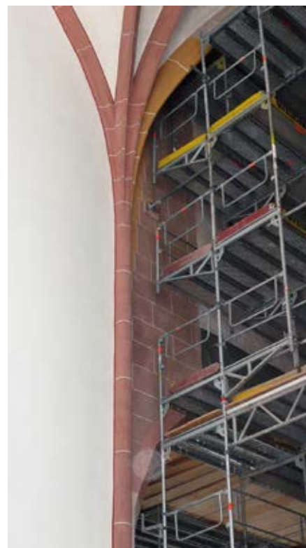
Übergang Chor–Langhaus, rekonstruierte Erstfassung mit der konsolartigen, gemalten Abtreppe seitlich der Mittelschiffdienste, Musterfläche 2013 (Foto: BLfD, Thomas Wenderoth)
