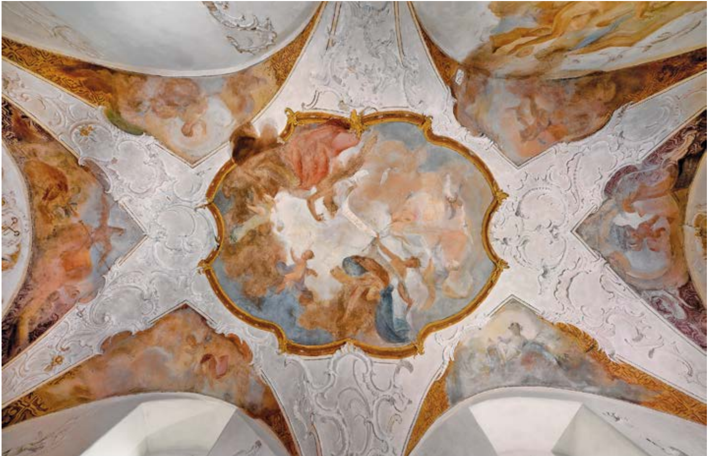
Gereinigtes und gefestigtes Gewölbe. Der Bestand ist gesichert, die Wirkung mit minimalen Eingriffen erheblich verbessert (Foto: FZB Ateliers, Gerchsheim)
