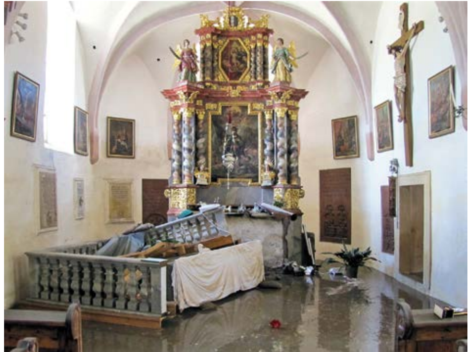
Passau, St. Achatius, Kircheninnenraum kurz nachdem das Hochwasser wieder abgelaufen war (Foto: Joh. Kallinger, Holzkirchen)
