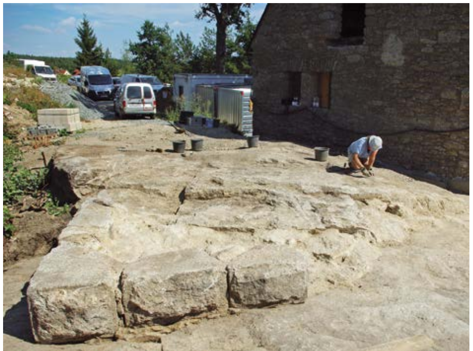
Burg Falkenberg, unterste Buckelquaderlagen des Turms während der Untersuchung; Blick von Norden auf das freigelegte Felsplateau (Foto: Mathias Hensch)
