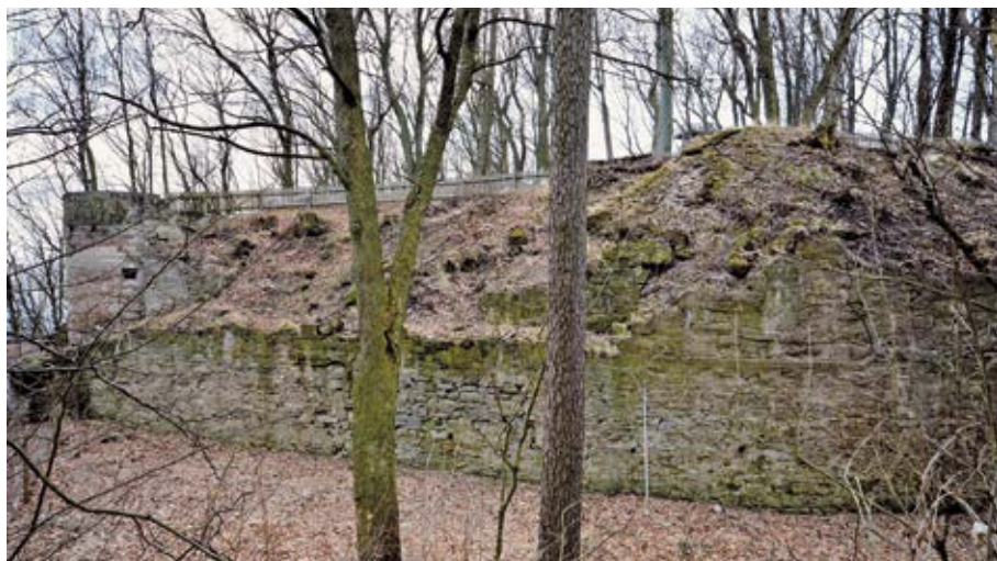
Zabelstein, Frontansicht der Hauptburg von Nordosten bei Maßnahmenbeginn 2013 (Foto: Büro für Burgenforschung, Joachim Zeune)
