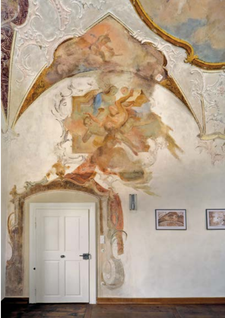
Konserviertes und mit Pastellkreide farbig eingestimmtes Freskendetail über der Tür. Der Absatz der im 19. Jh. eingezogenen Zwischendecke für Wohnzwecke ist noch erkennbar (Foto: FZB Ateliers, Gerchsheim)
